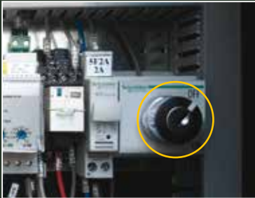
▲ EIN / AUS FI - Schlüsselschalter
