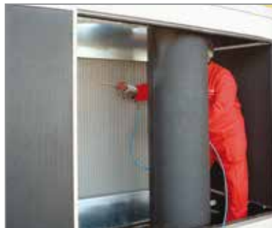
▲ Einfacher Zugang zur Kühlerreinigung
