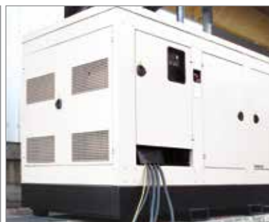
▲ Wettergeschützter großzügiger Kabeleingang
