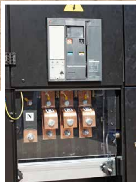
▲ Polycarbonat Schutzabdeckung für Kupferschiene
