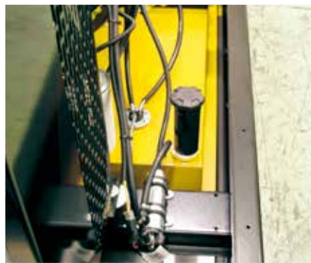
▲ Auffangwanne für Betriebsstoffe, Kraftstoff und Säuren
