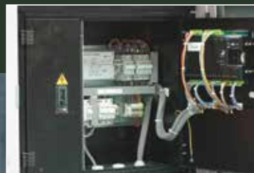
▲ EIN / AUS FI - Schlüsselschalter
