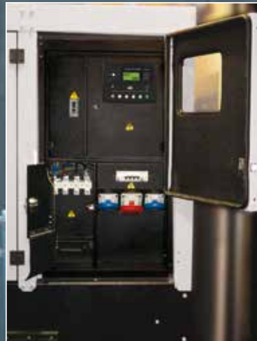
▶ Lastabgang über Kupferschienensystem, mit Sicherheitsschalter und Steckdosenkombination
