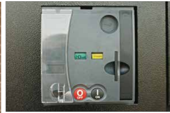
▲ Motorisierter Hauptschalter für die Synchronisierung von Stromerzeugern
