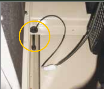
▲ Leckageüberwachung für Auffangwanne
