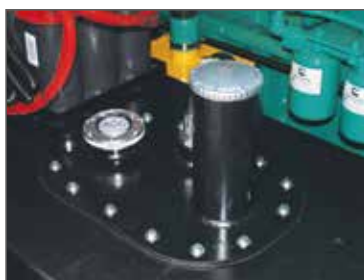
▲ Mechanical fuel level reading placed next to the filling point Lecture mécanique niveau carburant placé à côté du point de remplissage
