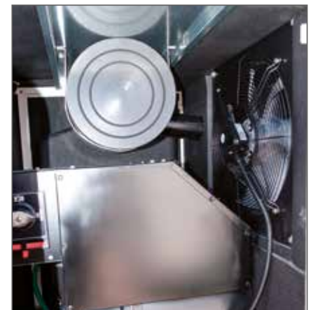
▲ Silencer in compartment completely insulated, with spark arrester. Silencieux dans le compartiment entièrement isolé, avec pare-étincelles
