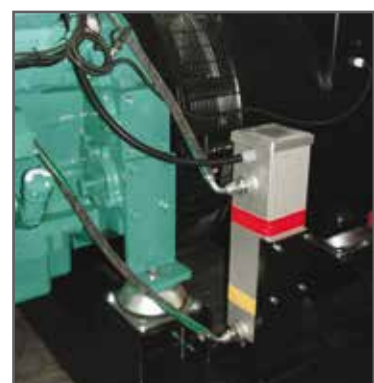
▲ Elektrische Kühlwasserheizung
