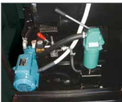
▲ Automatische Kraftstoffnachfüllung bestehend aus: Elektrischer Pumpe, Handpumpe, Pumpensteuerung, 4 Niveauschalter, Handschaltung zwischen Hand- und Elektrobetrieb
