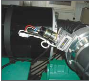
▲ Elektrische Chalmers Verbrennungsluft Schnellverschluss Klappen.
