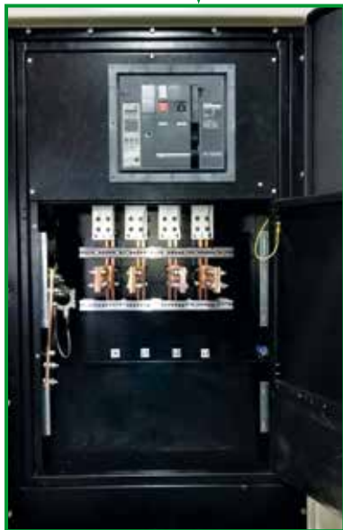
Lastabgang Kupferschienensystem
