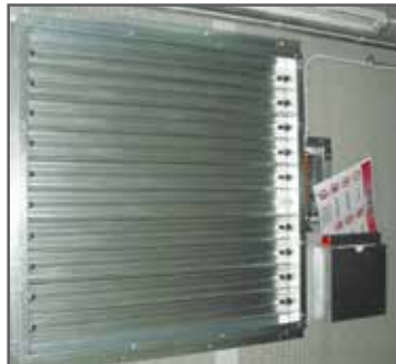
▲ Die motorisierten Jalousieklappen sind frostsicher beheizt und garantieren den sicheren Start des Stromaggregats
