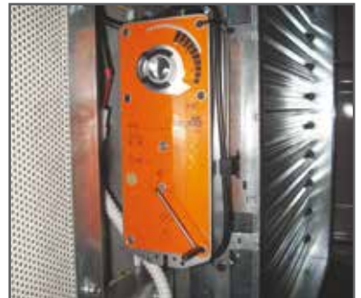
▲ Die motorisierten Jalousieklappen sind frostsicher beheizt und garantieren den sicheren Start des Stromaggregats
