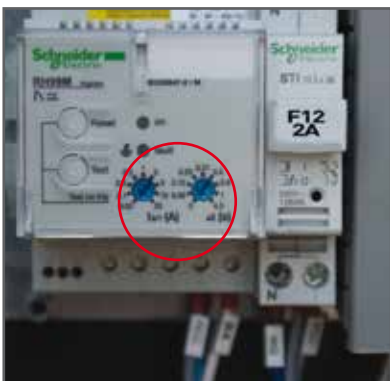
▲ Einstellbarer FI Schutzschalter
