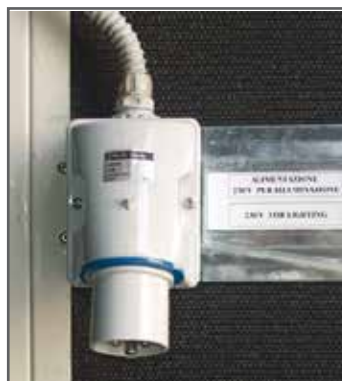
▲ Externe Spannungsversorgung 220-240VAC
