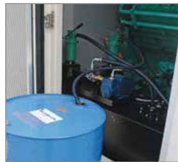
▲ Elektrische Pumpe zur Befüllung und Entleerung des Motorenöls Electric oil refilling/emptying pump
