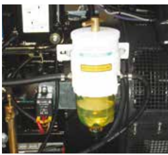
▲ Wasserabscheider vom Typ Racor
