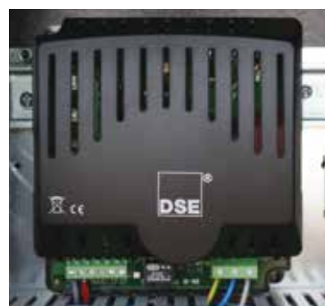
▲ Batterieladegerät
