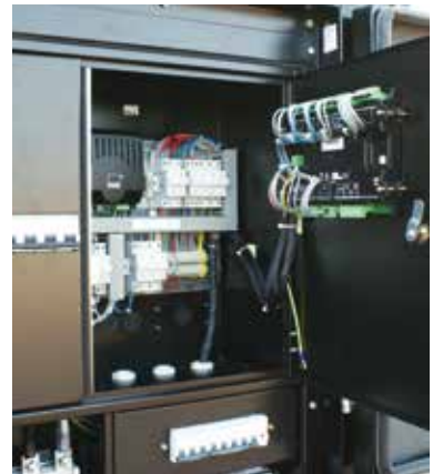
▲ Einfacher Zugang zur Aggregatsteuerung
