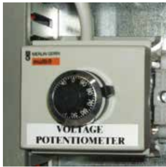
▲ Spannungspotentiometer
