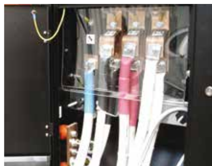
◀ Klemmbrett zur Synchronisierung mit dem Stromnetz
